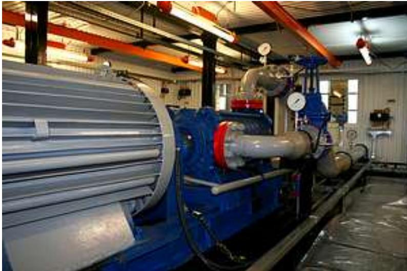
**Станция насосная перекачивающая** предназначена для перекачки сырой и товарной нефти, очищенной пластовой воды, пресной воды и других жидкостей, закачки воды в пласт для поддержания пластового давления, закачки в поглощающие скважины и т.п. Также изготавливаются насосные станции, которые могут использоваться в качестве подпорной, противопожарной насосной и др. Область применения - цеха добычи, подготовки и транспорта нефти, газа, цеха поддержания пластового давления.
