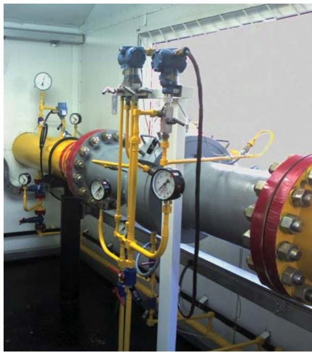
**Система измерения количества и показателей качества газа СИКГ** предназначена для автоматического коммерческого и оперативного учета газа, путем измерения количества и физико-химических показателей качества перекачиваемого газа.
